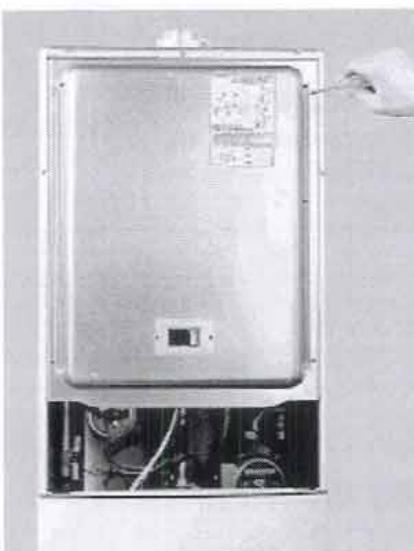
Fig. 29. Løsn og fjern de 5 skruer, der fastholder brænderens beskyttelsespanel og fjern selve panelet.
