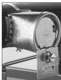
Trækstabilisator på vandret røgrør
